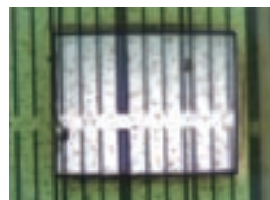
ポリイミド膜の剥離
